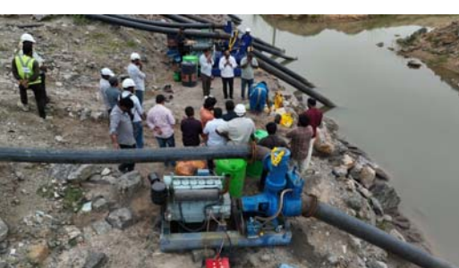
పూజ చేసిన జలవనరుల శాఖ , ఎం ఈ ఐ ఎల్ అధికారులు త్వరలో గ్యాస్ 1 నిర్మాణ పనులు ప్రారంభం ప్రస్తుతం కొనసాగుతున్న మట్టి తవ్వకం పనులు
